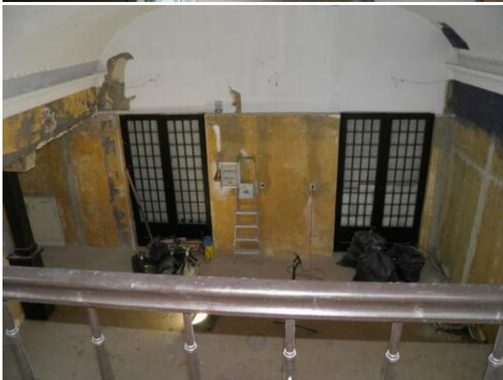
Blick in den Brauraum
